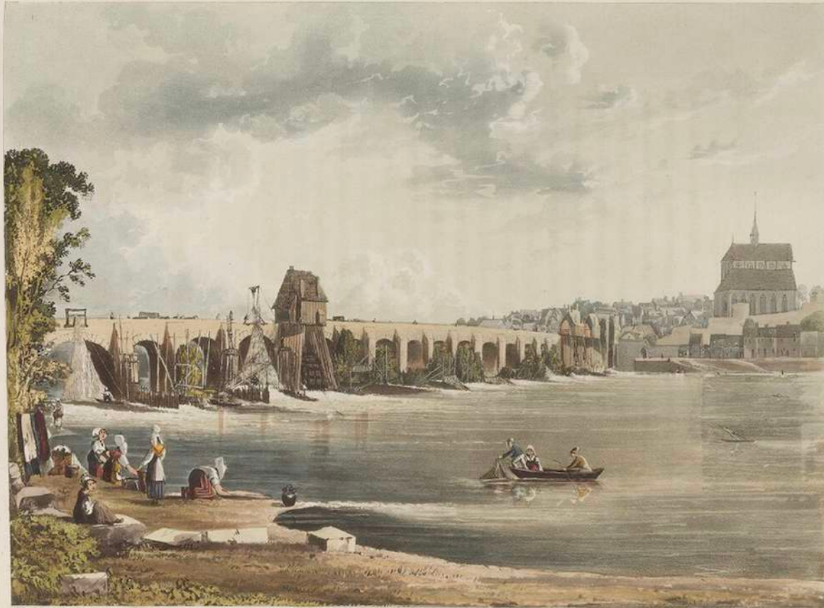
PONT DE L'ARCHE.
